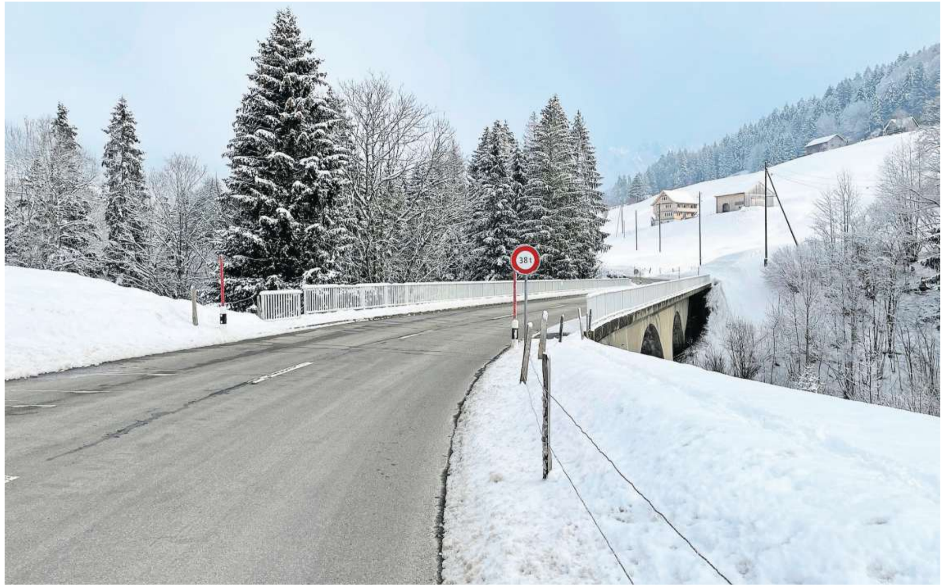
Bei der 120-jährigen Luterer-Brücke handelt es sich um eine der ersten Stampfbetonbrücken. Ein Gutachten stuft die Brücke als erhaltenswert ein.
