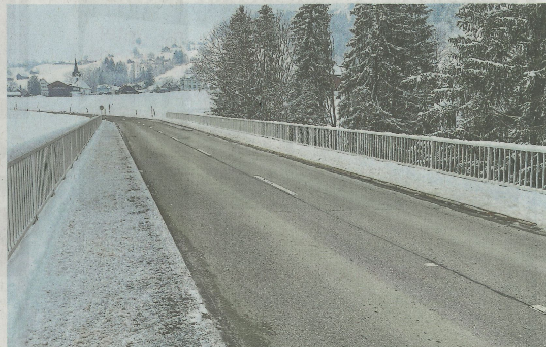
Brücke der Schwägalpstrasse über die Luterer bei Ennetbühl. Auf beiden Seiten der Brücke macht die Strasse enge Kurven. Bild: Sabine Camedda
